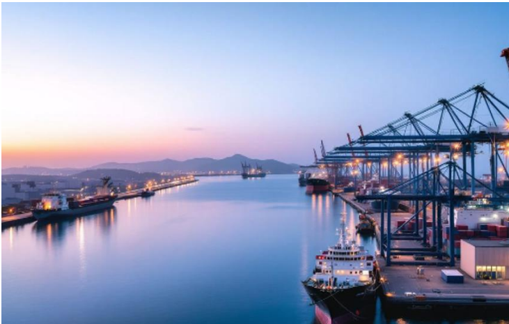
Modernización del Puerto del Callao
