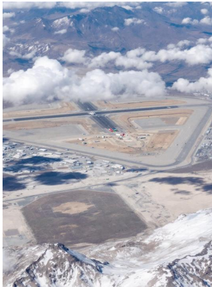
Aeropuerto Internacional de Chinchero
