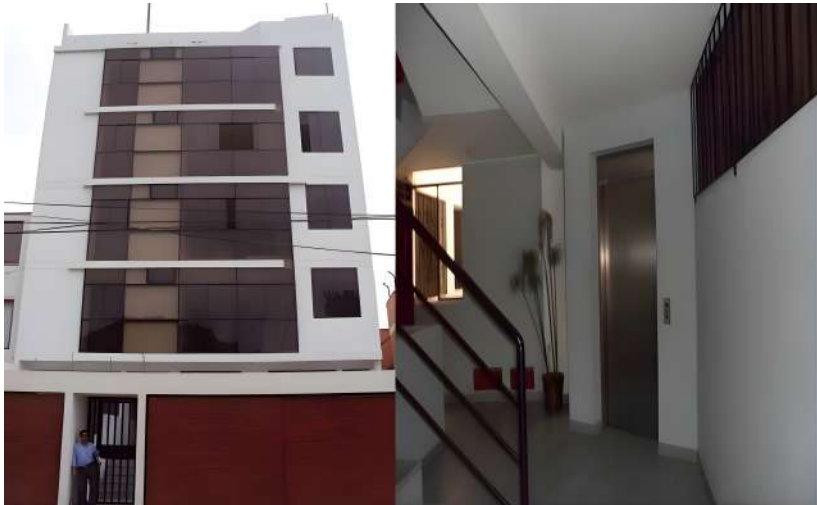
Nota. Ascensor - Residencial Santa Domitila, Lima Cercado.
